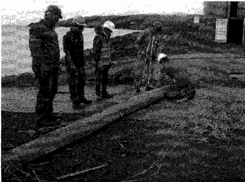
استفاده از گیاهان موجود در منطقه که در داخل تورهای مشبک فلزی قرار می گیرند
