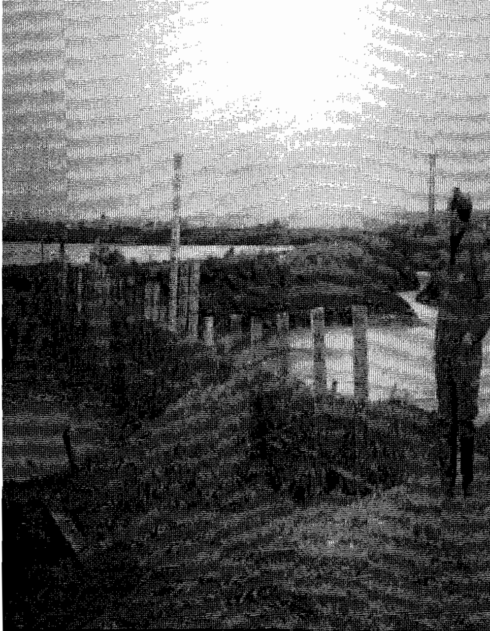
سد جمع کننده آلودگی نفتی از جنس کاه که توسط سیم محکم شده اند
