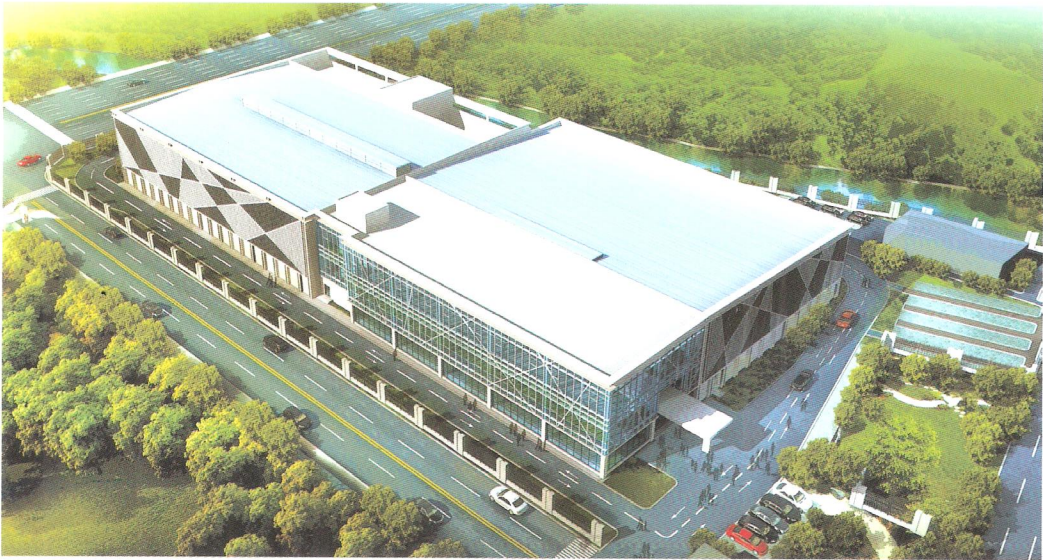
■ 泽国沈桥厂房
