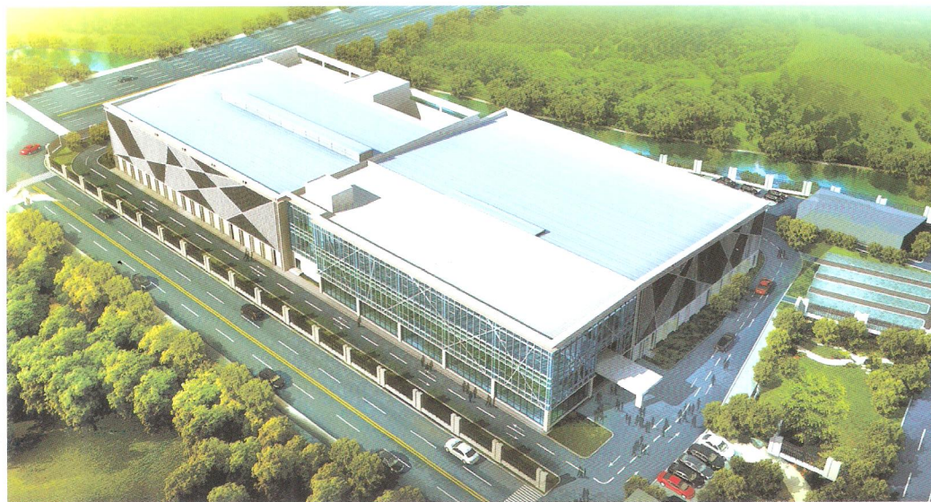
■ 泽国沈桥厂房
